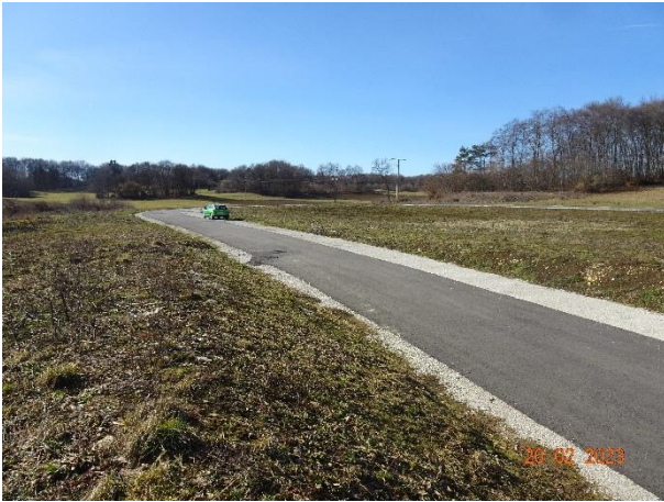
Blick nach Südwesten. Im Vordergrund der südliche Verlauf der U-förmigen Straße „Dellerhofen“, links und rechts davon das Plangebiet. Im Hintergrund nicht zum Plangebiet gehörende Ackerflächen und Feldgehölze mit Saumvegetation.
